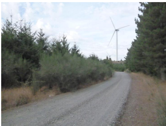
Foto 15 – Acesso e local previsto para o aerogerador 29
